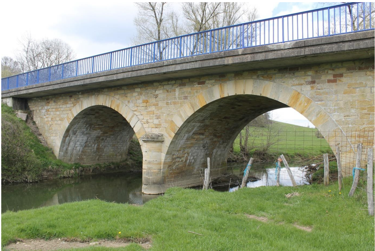
Le Pont à conforter sur l'Avière à Frizon
